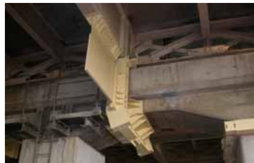
写真-5.3.3 桁端ダンパー (キールダンパー)
