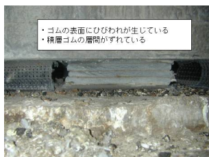
写真-3.5.1 ゴム支承の支承部の損傷状況
