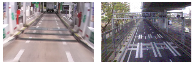
(a) 高速道路料金所 (b) 国道 写真-3.7.2 軸重計設置状況(定置式)
