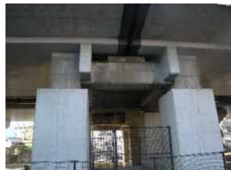
写真-4.3.1 特殊なラーメン式橋台
