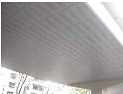
写真-5.4.2 裏面吸音板の設置例
