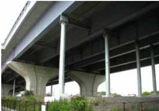
写真-5.3.4 センターダンパー設置状況
