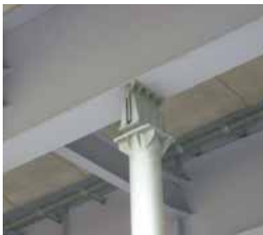
写真-5.3.5 センターダンパー装置外観
