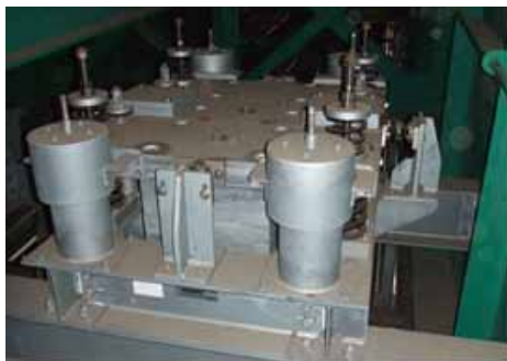
写真-5.3.1 TMD (粘性減衰)
