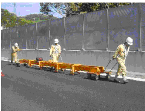
写真-3.8.1 8mプロフィールメーター
