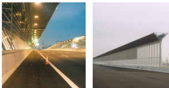
(a) 逆L型遮音壁 (b) 分岐型遮音壁 写真-5.4.1 大型遮音壁
