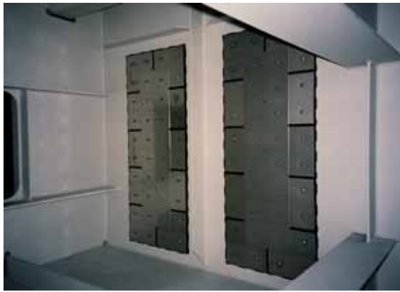
写真-5.3.6 連結型制振材取り付け後
