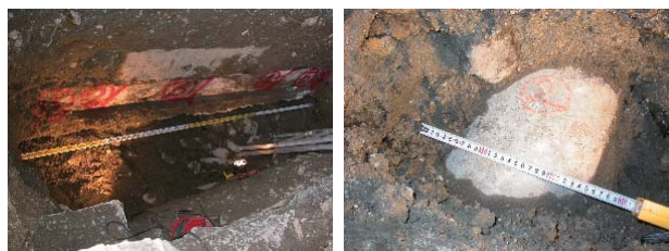
写真-1 ロッカー橋脚基礎杭の状況
