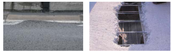
写真-3 上面増厚前の損傷状況（増厚前）
