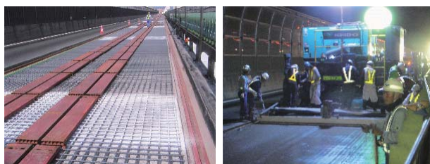
写真-2 床版上面増厚施工状況
