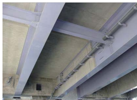
写真-4 床版下面増厚、鋼桁巻立て全景
