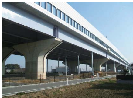
写真-5 センターダンパー全景
