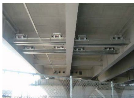
写真-6 TMD全景
