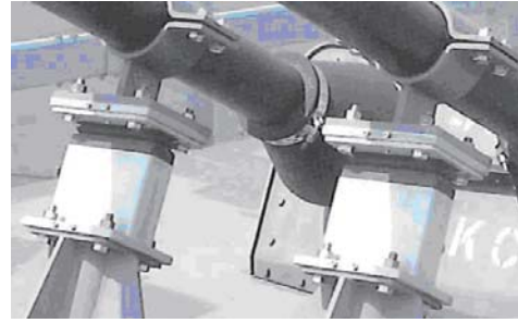
写真-2 粘性ダンパーの一例
