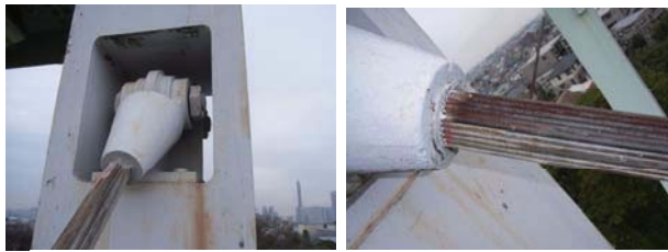
写真-1 ケーブル主塔側定着部
