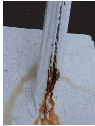
写真-3 ケーブル桁側定着部
