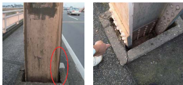
(a) V5 局所変形 (b) V1 コンクリート接触 写真-2 垂直材の損傷状況
