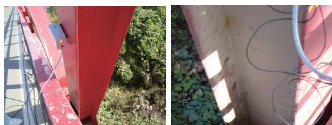
(a) 第1径間_上流側：健全 (b) 第1径間_下流側：腐食 (S1-D1u) (S1-D1l)
