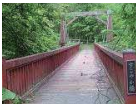
写真-2 すこやか橋(斜張橋)
