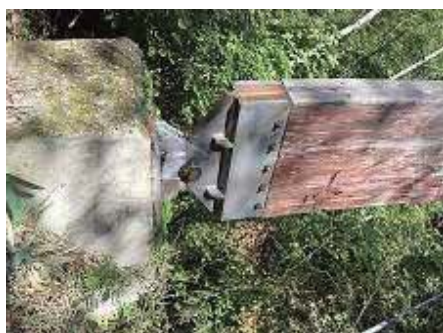
写真-3 ニールセン橋の結合部
