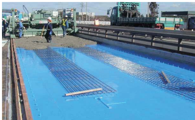
写真－3 SFRC 舗装施工状況
