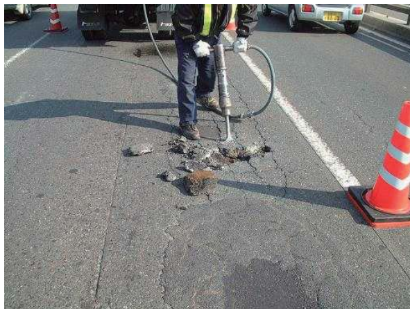
写真－１ 舗装損傷状況
