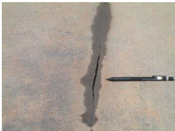
写真－２ 鋼床版き裂状況
