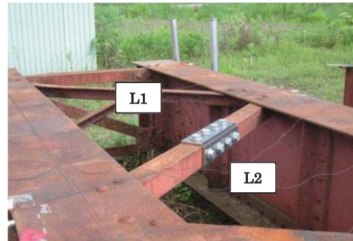
図 10 横構(健全状態)
