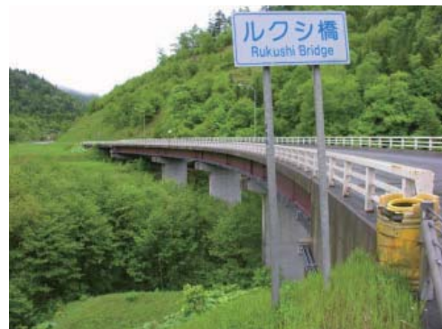
図 1 実験橋梁 A 全景
