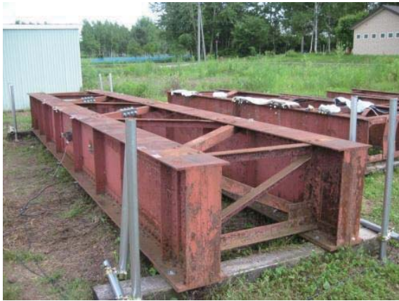
図 8 実験橋梁 B 全景(A-2 側から)
