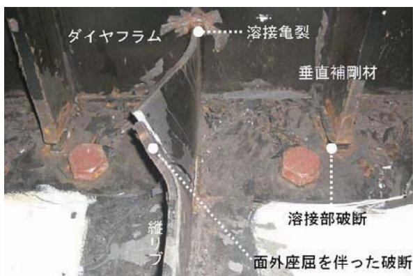
写真-3 固定支承部の損傷状況(GR桁)
