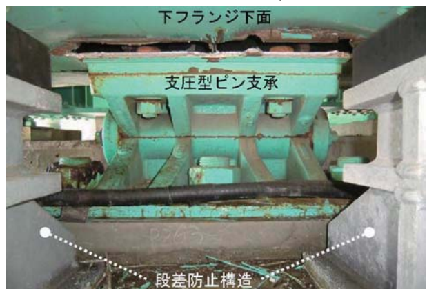
写真-2 固定支承部の損傷状況（GR 桁）
