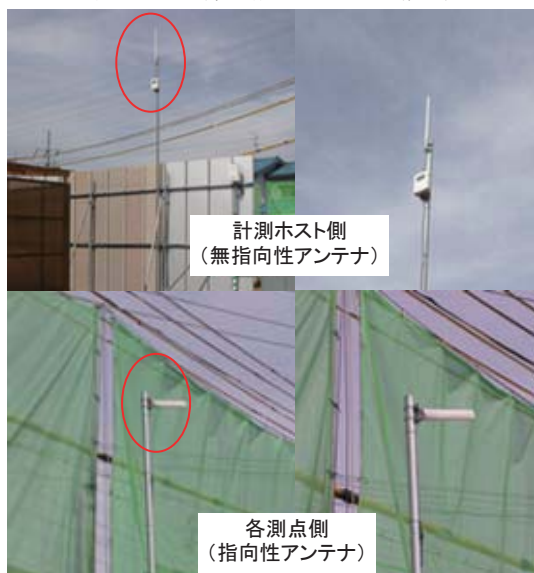
図-12 無線通信機器の設置状況
