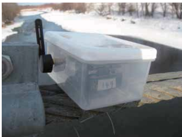
図-7 センサー設置状況
