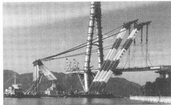
図-3.12 多々羅大橋 側径間先行架設
