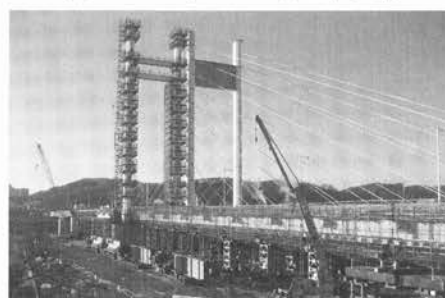
図-3.14 オールステージング工法の例
