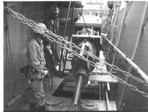
図-3.20 桁側引き込み装置の例
