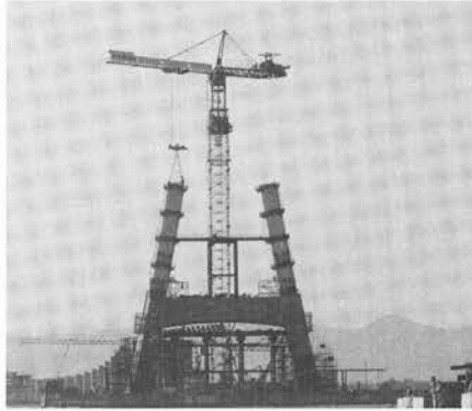
図-3.8 Nanjing No.3橋塔架設
