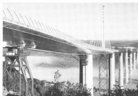
図-3.15 Millau 高架橋送り出し工法の例
