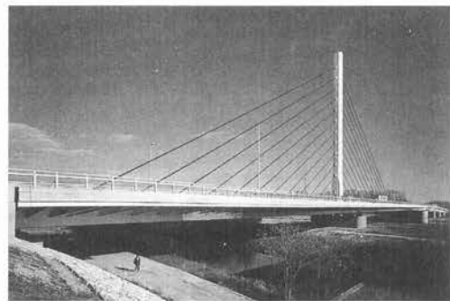
図-2.96 札幌内清柳大橋
