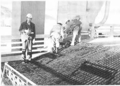
図-2.69 橋面の段差 (東神戸大橋)
