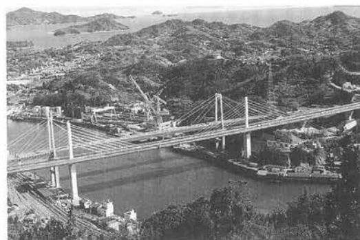
図-2.100 尾道大橋と新尾道大橋
