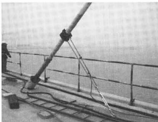
図-2.61 仮設制振用ケーブルの例
