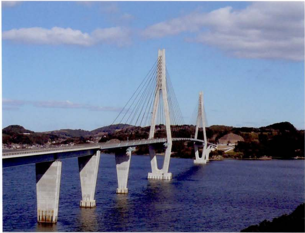
鷹島肥前大橋
