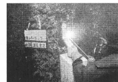
陽極水中溶接状況
