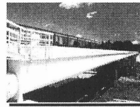
御引川水管橋 Al 100 \mu + 封孔処理、上塗
