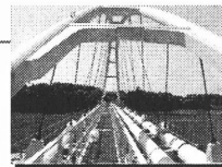
鬼怒川水管橋 Al 150 \mu + 封孔処理、上塗
