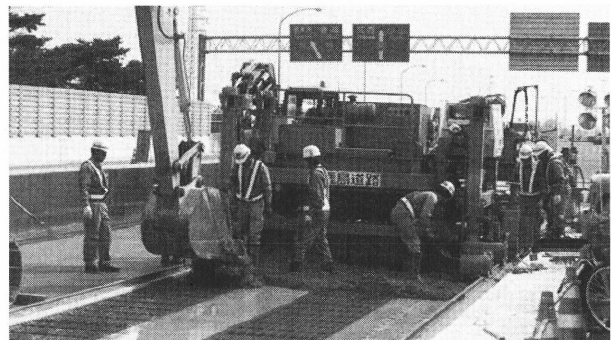
写真-5 コンクリートの打ち込み
