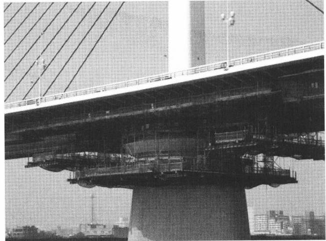
図-1 4 鋼製リング設置状況
