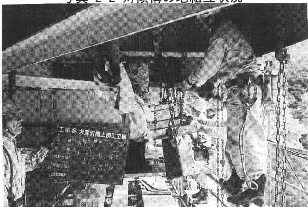
写真-2-3 工事用縦桁の設置状況
