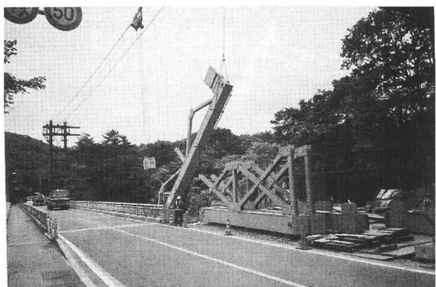
写真-2-2 対傾構の地組立状況
