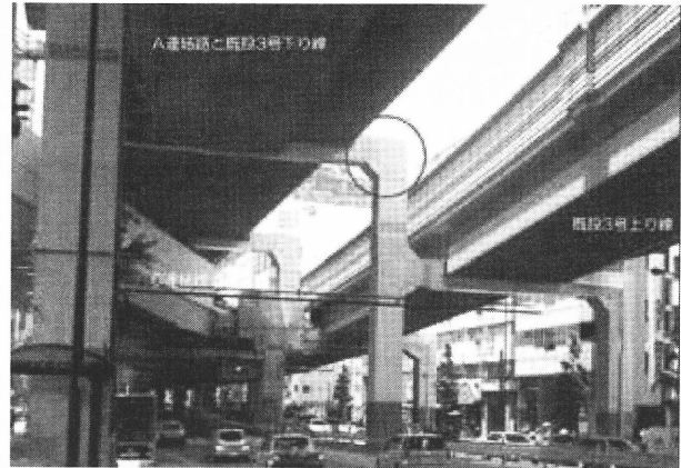
写真-3 橋脚補強当て板
