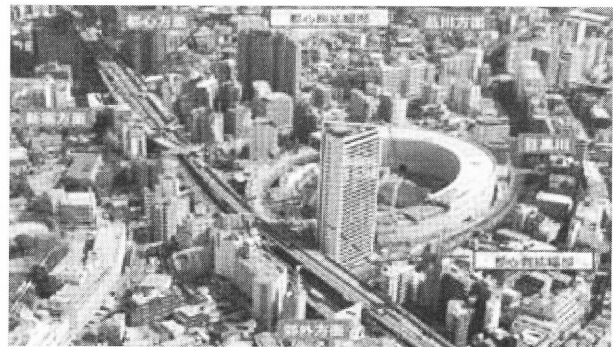
写真-4 大橋 JCT 全景(2009年3月撮影)
