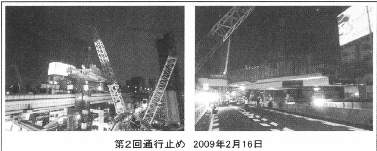
写真-2 高速3号渋谷線の通行止めを伴う架設状況
