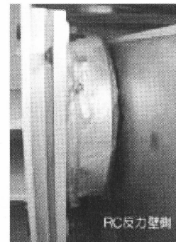
写真-1 アバット部の水平支承
