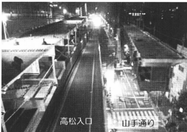
図-23 既設箱桁の撤去状況
