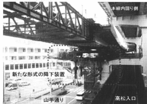
図-24 送出し架設での新たな降下装置
