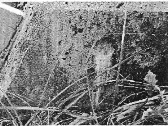
写真-10 アンカーコンクリート
