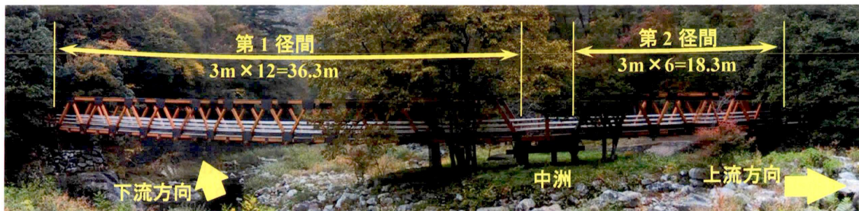
写真2 解体前の対象橋梁の全景（2003/11/06 撮影・4枚を合成）
