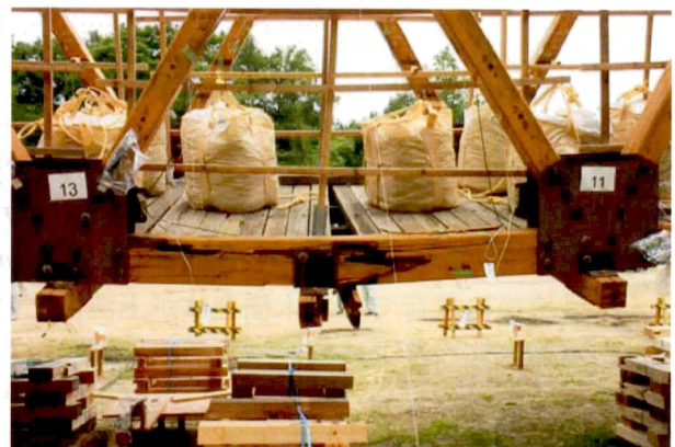
写真5 部材破壊状況（一次破壊）
