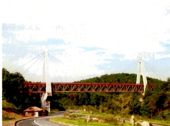
写真-2.4.1 用倉大橋の全景
