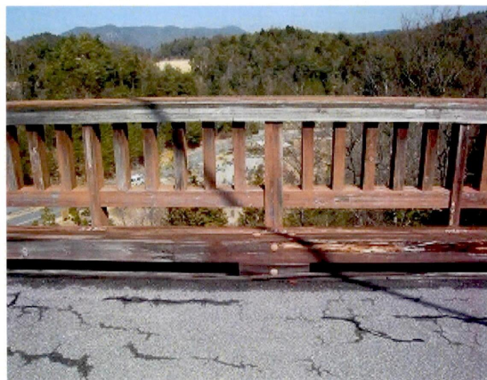
写真-2.4.2 用倉大橋の地覆と高欄
