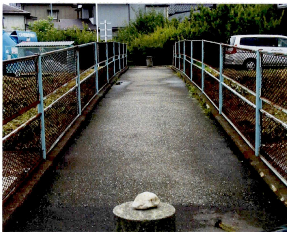
写真-1.6.1 橋面状況
