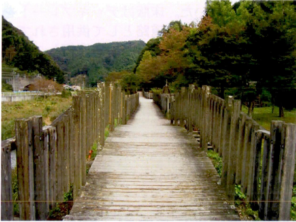
写真-1.6.3 路面状況
