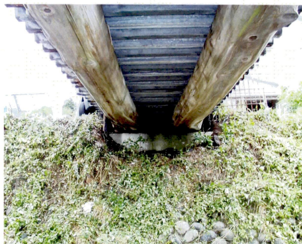
写真-1.6.2 桁下および橋台状況
