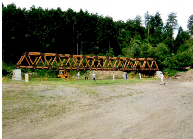
写真-1.6.5 全体状況
