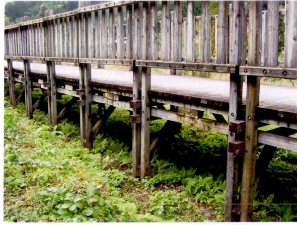
写真-1.6.4 骨組および施設状況
