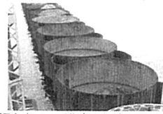
鋼矢板セル護岸(直線形鋼矢板)
