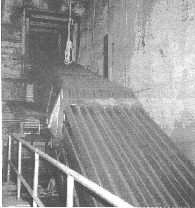
写真-11 ケーブルアンカー部
