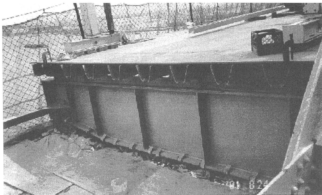
写真-8 張出し部の鋼床版
