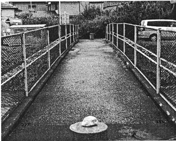
写真-1 橋面状況
