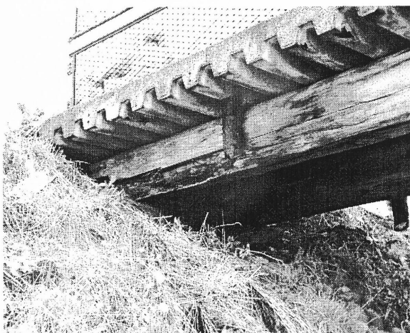
写真-3 橋台部主桁状況
