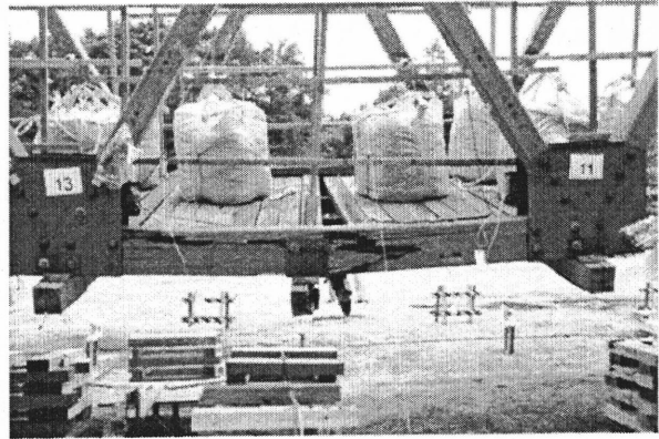
写真5 部材破壊状況（一次破壊）
