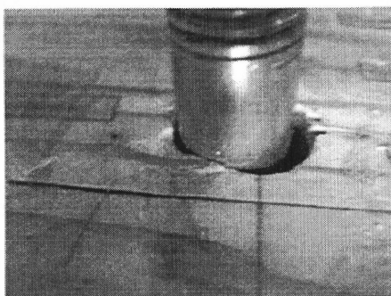
写真-3 破壊状況(埋込み破壊)
