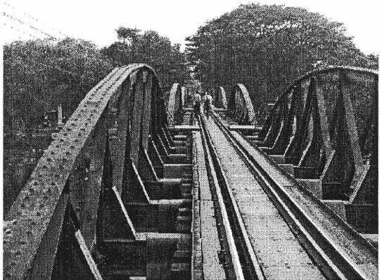
写真-11 現在のメークローン橋梁 曲弦トラス橋は建設当時のまま
