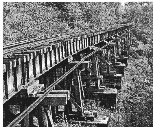
写真-2 現在のワンポー木製棧道橋
