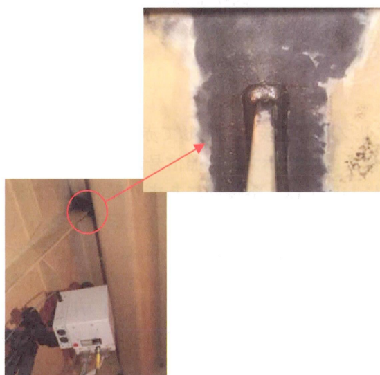
図-9 測定対象（鋼床版箱桁橋）
