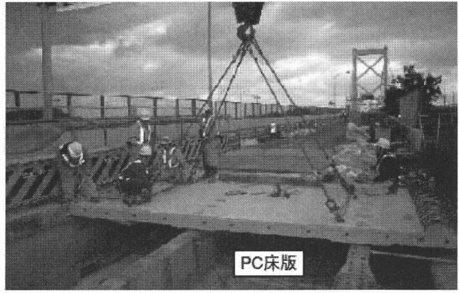
写真－8 プレキャスト PC 床版への取り換え事例
