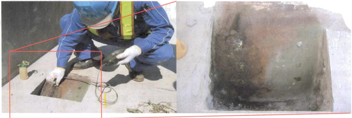
図－8 NEXCO のコンクリート埋設鋼部材調査（単弦ローゼ橋のアーチリブの例）
