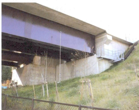
写真－5 北関東自動車道 南指原川橋
