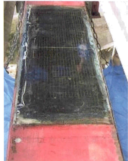
写真－6 浅利川橋の補強例
