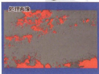
写真－2 ペイントビューによる塗膜劣化部の抽出状況
