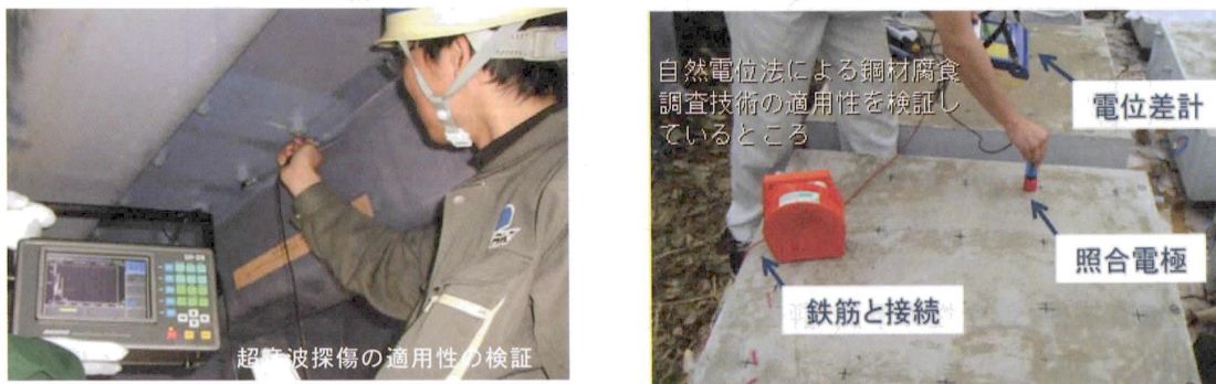
(a) 超音波探傷によるき裂の調査
