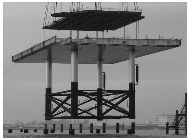
図-6.4.2 ジャケットの据付状況
