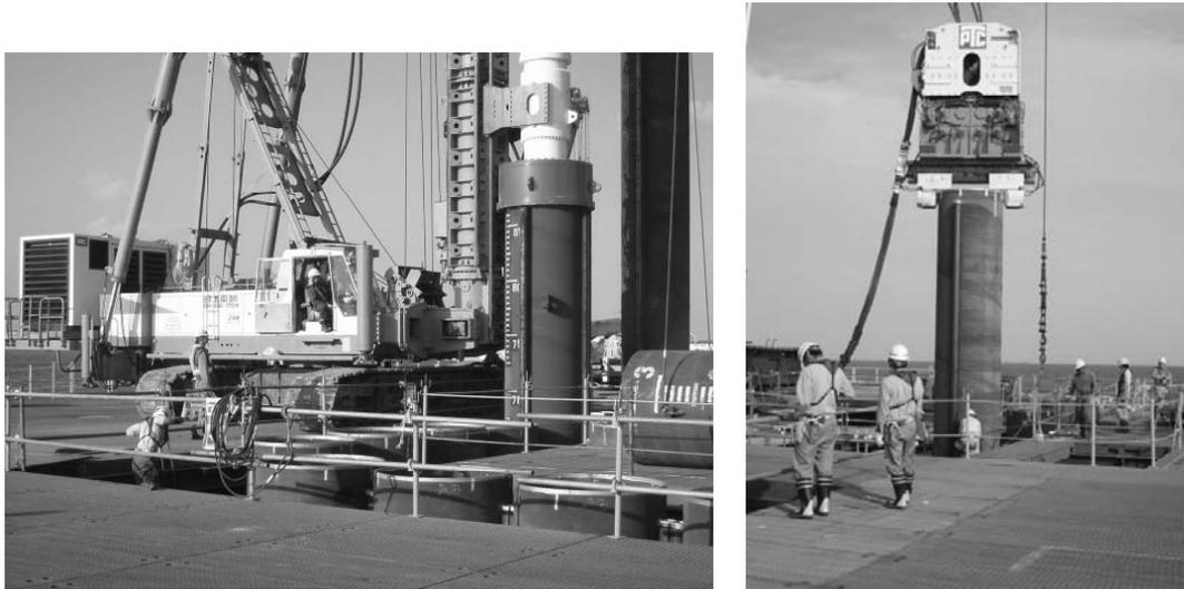
写真-6.5.2 (左) 油圧ハンマによる打設状況 (右) パイプロハンマによる打設状況
