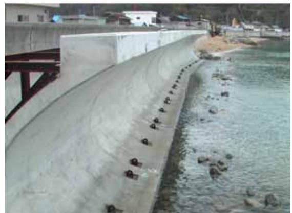
写真-6.3.4 フレアブロック据付完了
