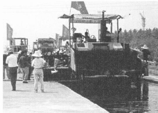
写真-4.5 2<sup>nd</sup> Yangtze橋のエポアス舗装<sup>4-17)</sup>
