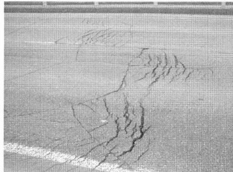
写真-2.28 鋼床版舗装のずれと剥離
