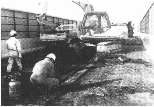
写真-2.25 グースアスファルトの撤去の例
