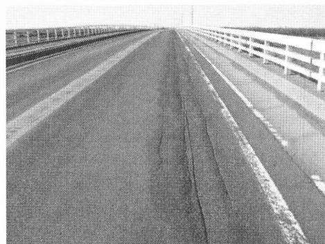
写真-2.2 鋼床版舗装の主げた上の縦ひび割れ
