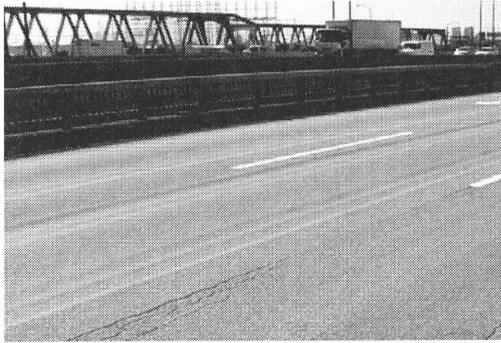
写真-2.29 鋼床版舗装のわだち掘れ
