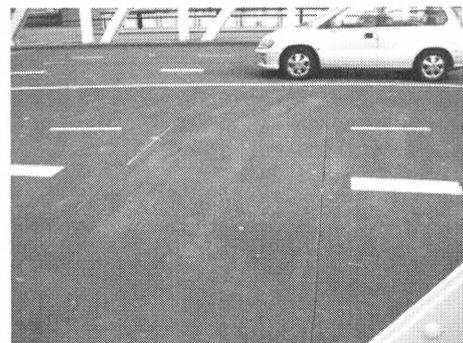
写真-2.23 開閉橋（オランダ）の薄層樹脂舗装
