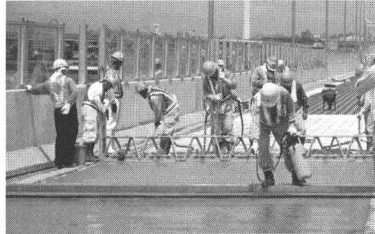
写真-4.12 新川渡河部の SFRC 舗設
