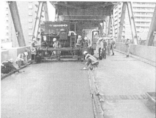
写真-4.18 高松地区高架橋のSFRC舗装<sup>4-31)</sup>
