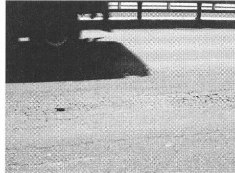
写真-2.26 鋼床版舗装のポットホール
