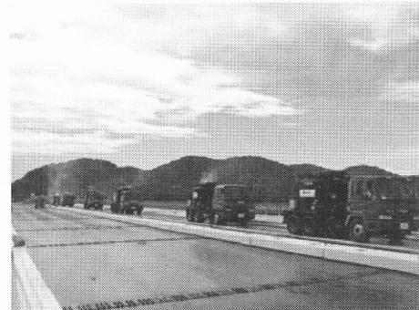
写真-2.12 クッカー車によるゲースアスファルト搬入
