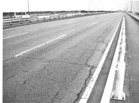
写真-2.27 鋼床版舗装のひび割れ
