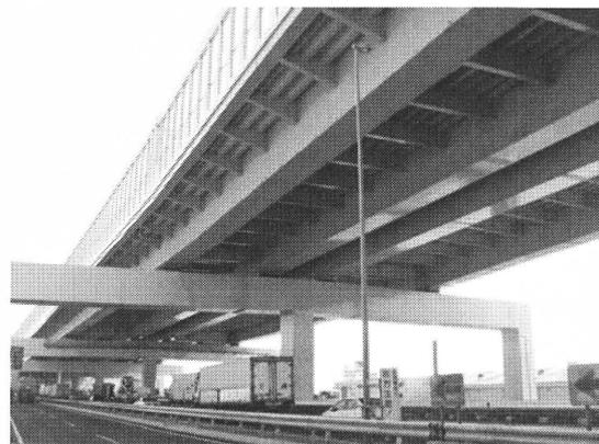
写真-3.1 合理化鋼床版構造（第二東名高速道路）
