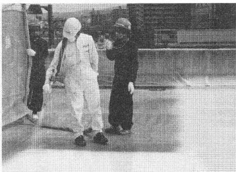
写真-2.7 ウレタン樹脂系の床版防水材料の施工例
