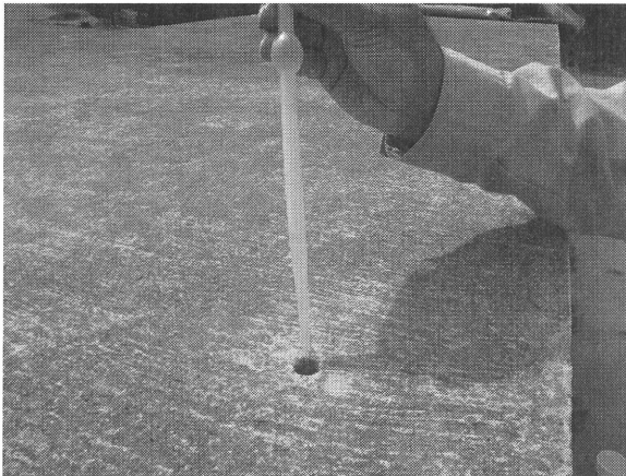
写真-5 剥離部への注水状況
