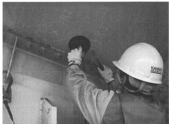
写真-4 打音法の調査状況
