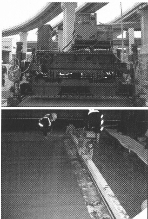
写真-1 試験施工で用いたフィニッシャー (上：大型フィニッシャー、下：小型フィニッシャー)
