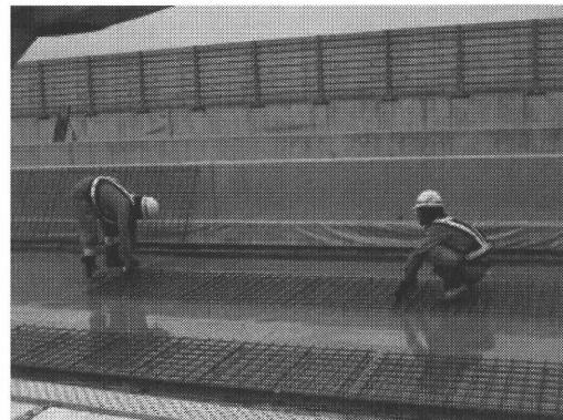
写真—2.2 CFRP グリッド筋の設置
