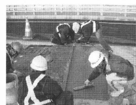
写真-6 早強 ECC の打設
