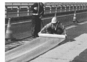
写真-5 アラミド繊維シートの接着
