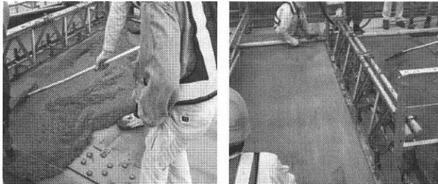
(a)モルタルの敷きならし
