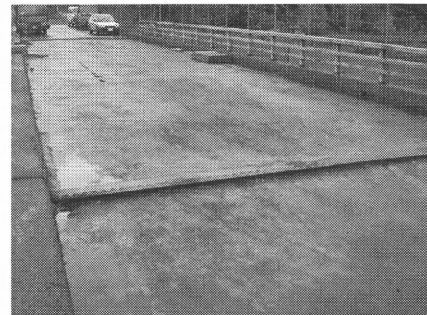
写真-3 床版上面の状況
