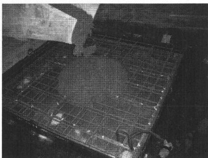
コンクリートの打設
