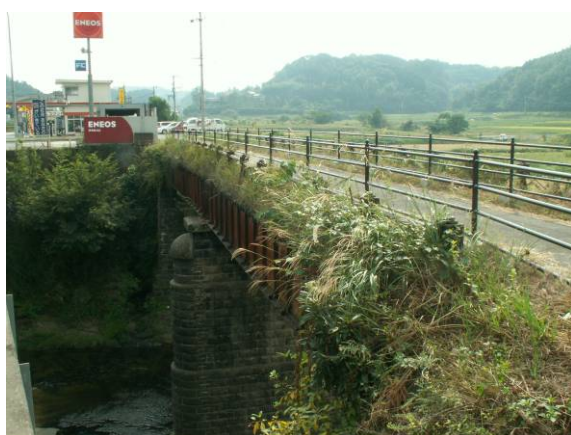
写真-3.2.15 高欄全景
