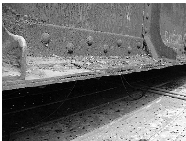
写真-1.2.11 主桁の状況（支間部）
