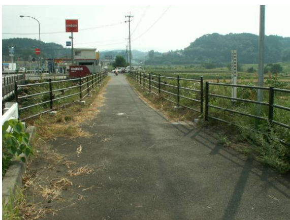
写真-3.2.11 取付状況(現在)(大分側)
