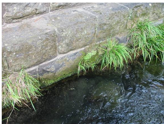
写真-3.2.34 橋脚喫水面
