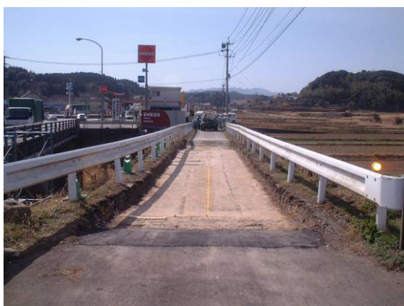
写真-3.2.9 取付状況(調査時)(大分側)
