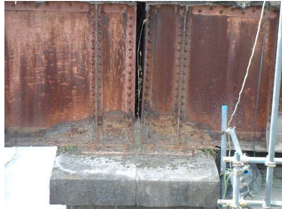
写真-3.2.30 橋脚橋座
