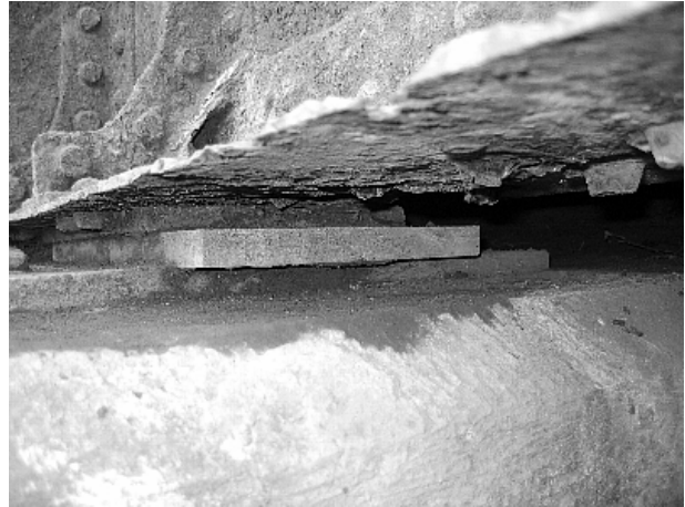
写真-1.2.15 支承(A2 橋台側)
