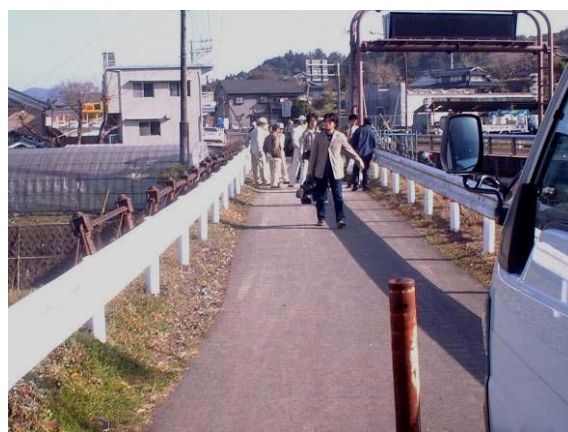
写真-3.2.10 取付状況(調査時)(佐伯側)
