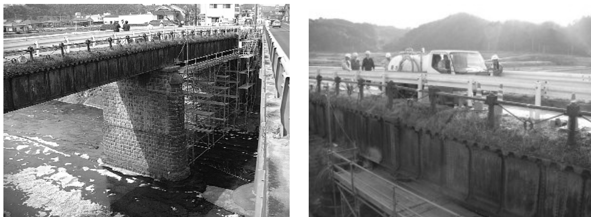
写真-1.3.1 橋梁外観および静的載荷試験状況
