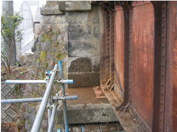
写真-3.2.29 橋台橋座
