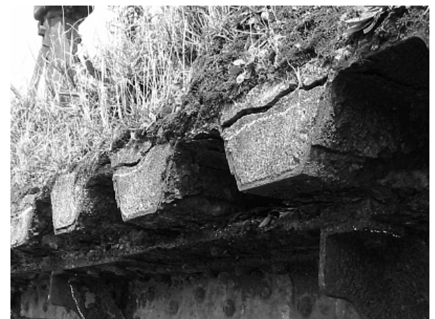
写真-1.2.3 床版張出し端部状況
