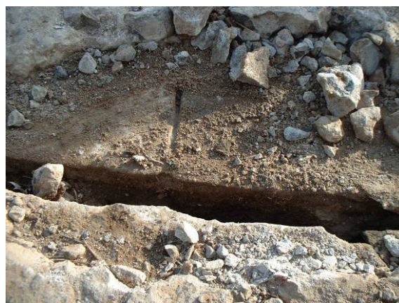
写真-3.2.28 橋面遊間
