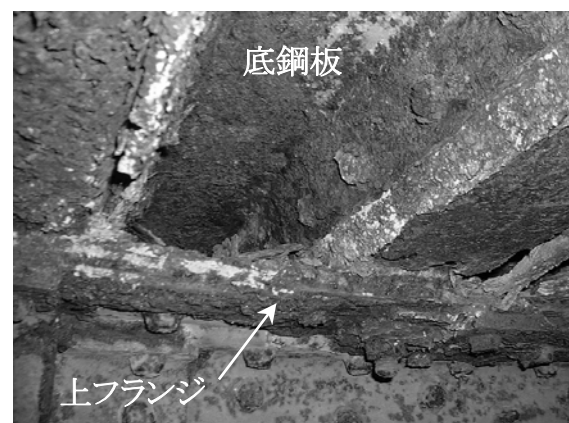
写真-1.2.7 床版-桁結合部（桁内面）
