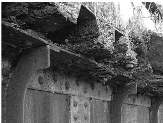
写真-1.2.6 床版-桁結合部（桁外面）
