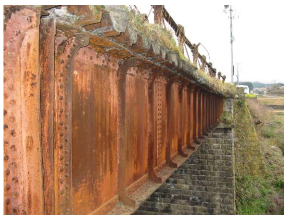
写真-3.2.13 主桁外側
