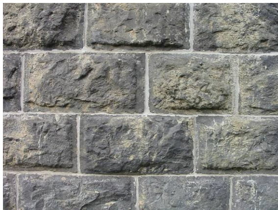
写真-3.2.32 橋脚石積み
