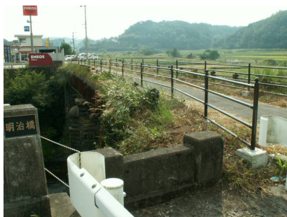
写真-3.2.17 高欄端部
