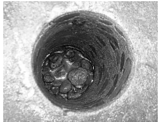
写真-1.2.5 床版コア抜き部状況
