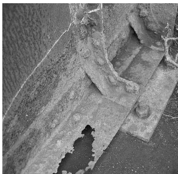
写真-1.2.10 主桁の状況（支点部）
