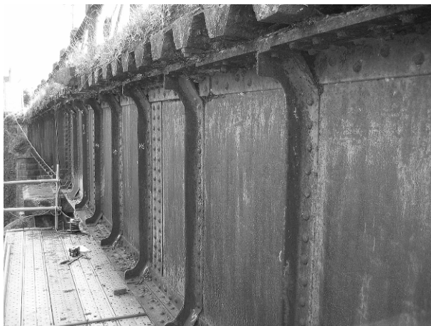
写真-1.2.8 主桁の状況（桁外面）
