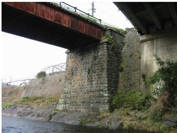
写真-3.2.31 橋台全景
