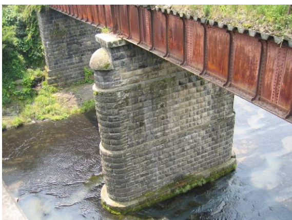
写真-3.2.33 橋脚全景
