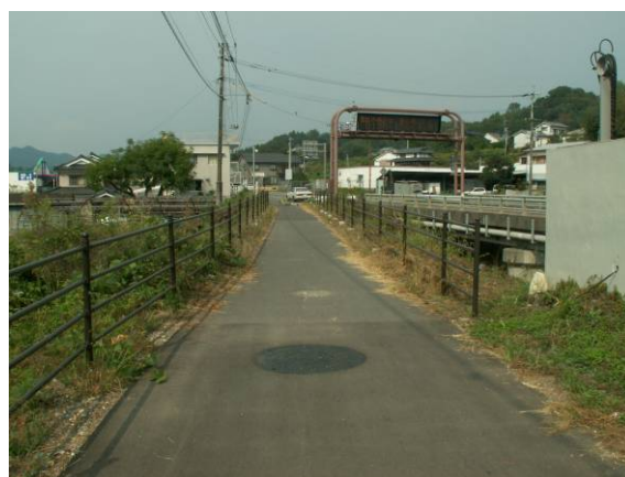
写真-3.2.12 取付状況(現在)(佐伯側)
