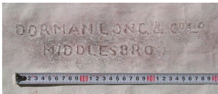
写真 - 2.3.1 波型プレートの刻印 (長田大輔氏採拓)
