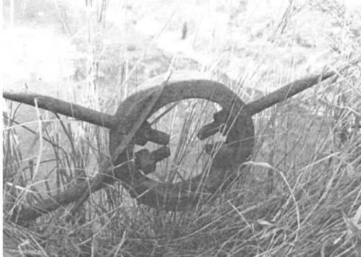
写真 - 3.4.1 高欄ブレースと円形金具
