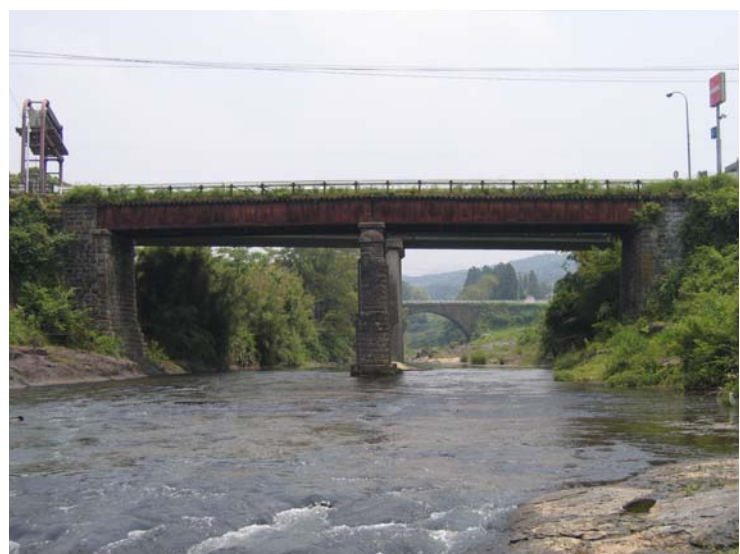
写真-1.1.2 現在の明治橋の状況
