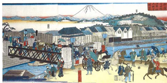
写真 - 2.2.2 吉田橋(横浜)明治2年(1869) [日本橋梁建設協会, 2004]
