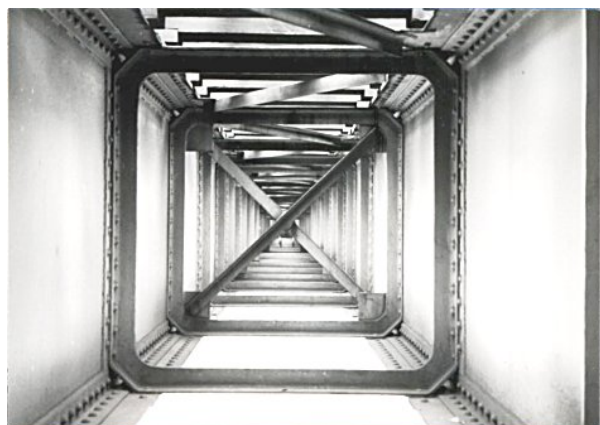
写真 - 3.2.4 多摩川橋梁の補強 [ 土木学会，2004 ]
