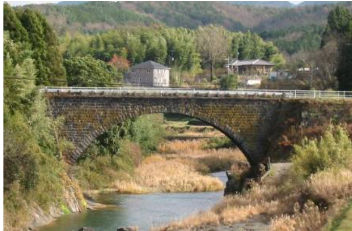
写真-1.1.3 明治橋付近の石橋（仮屋橋（旧安政橋））
