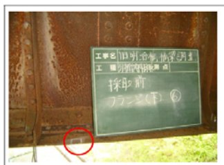
主桁下フランジ
