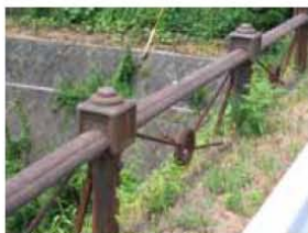
高欄（欄干、手すり）
