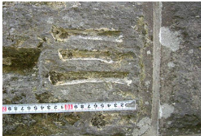
写真 - 3.3.2 橋脚石の切り込み(漢数字)
