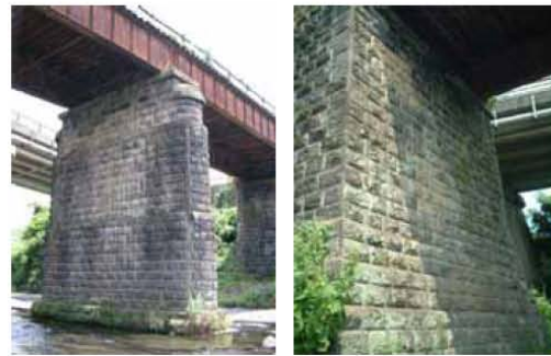
石積みの橋脚
