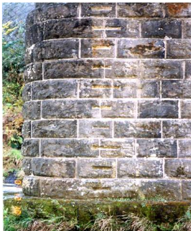
写真 - 3.3.1 橋脚石の切り込み
