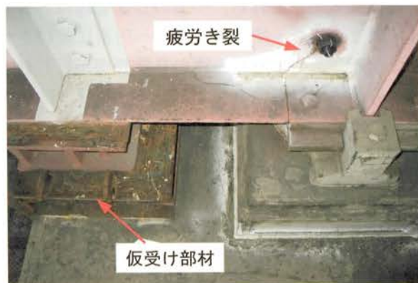
写真7.10 応急処置の例
