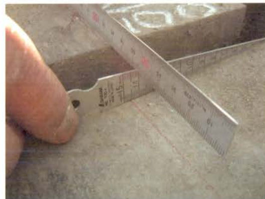
(c) 伸縮装置に生じた段差
