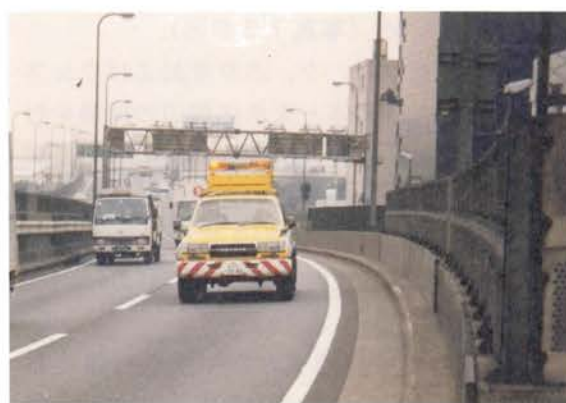
写真7.1 巡回車による日常点検
