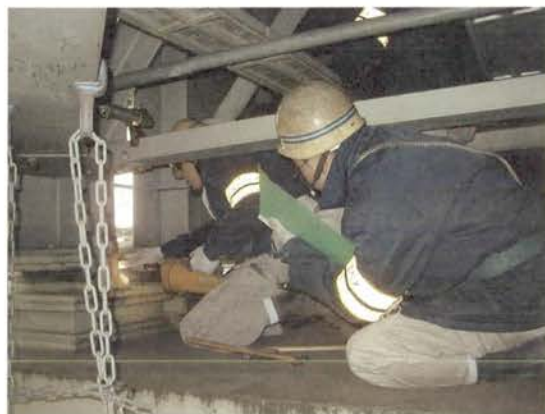
写真7.3 点検作業中の状況
