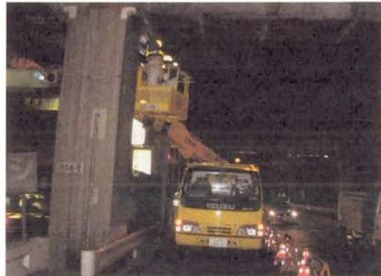
写真7.2 高所作業車による点検
