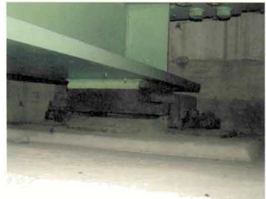
写真7.17 損傷加速期
