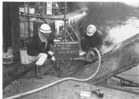
写真 4.3 無収縮モルタル注入状況 (転載)
