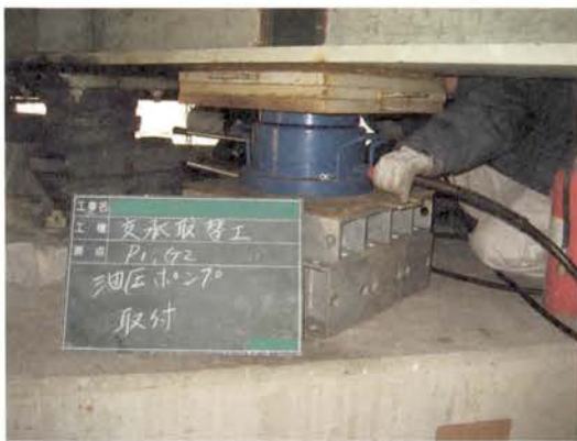
(c) ジャッキアップ
