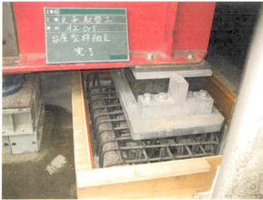
(a) 配筋・型枠
