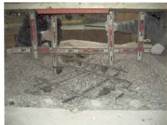
(f) アンカーボルト切断
