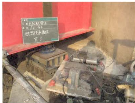
(e) 支承撤去
