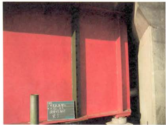
(b) 補強リブの設置
