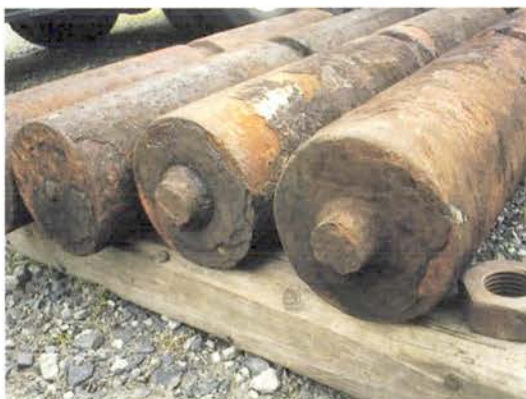
(b) ローラーの腐食
