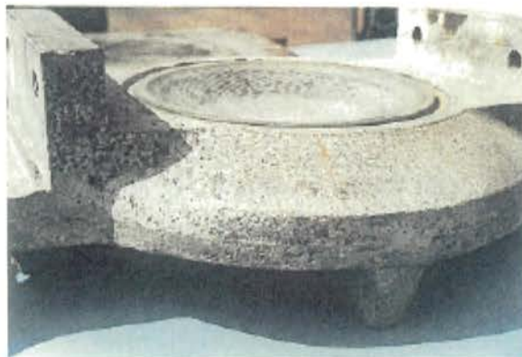
写真 3.30 供用十数年経過した BP・A 支承の外観
