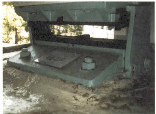
写真 3.33 ローラーの抜け出し
