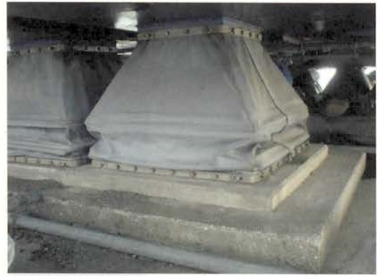
写真 3.17 支承の保護カバー
