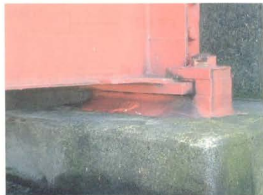
写真 1.1 線支承の適用例
